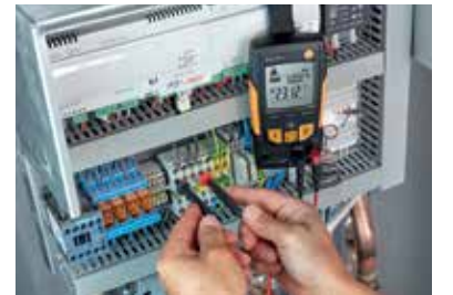
Bir ısı pompasının şalt dolabında gerilim testi
