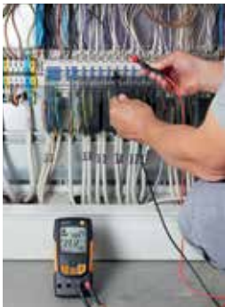
Şalt dolabında gerilim testi
