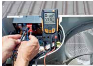
Diş soğutma ünitesi üzerinde gerilim ölçümü
