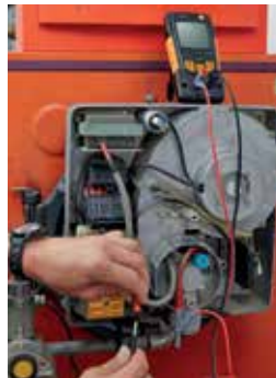
İyonizasyon akımı ölçüm kurulumu
