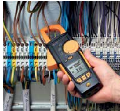
Şalt dolabında akım ölçümü
