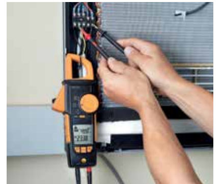
Havalandırma ünitesi üzerinde gerilim ölçümü
