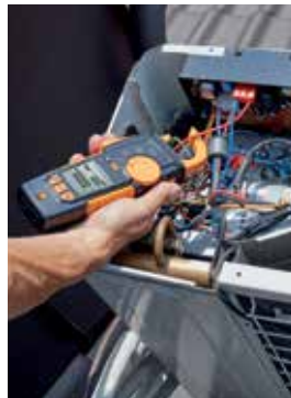
Bir dış soğutma ünitesine pens ampermetreyi takma
