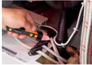
Bir kompresör üzerindeki gerilim kaynağının ilk testi
